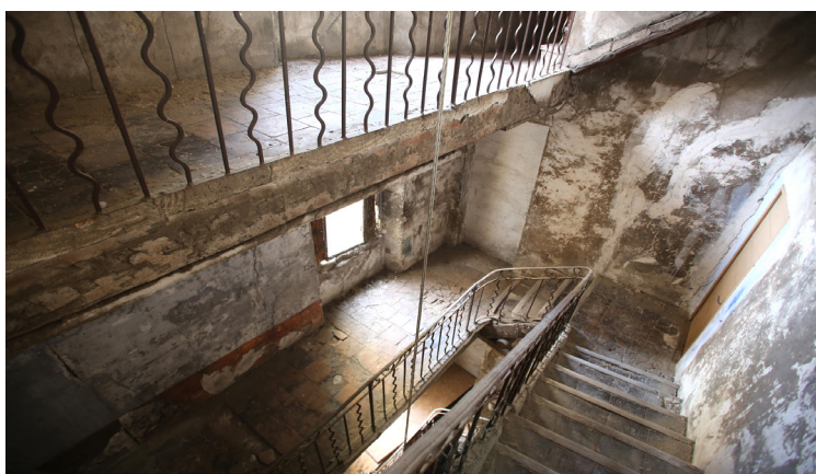
AVANT RESTAURATION Escalier immeuble Beaucaire © DPI - Ville de L'Isle-sur-la-Sorgue
