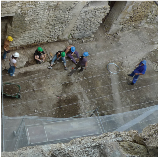
Montage des filets de protection par les services techniques
