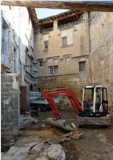
Terrassement de la cour
