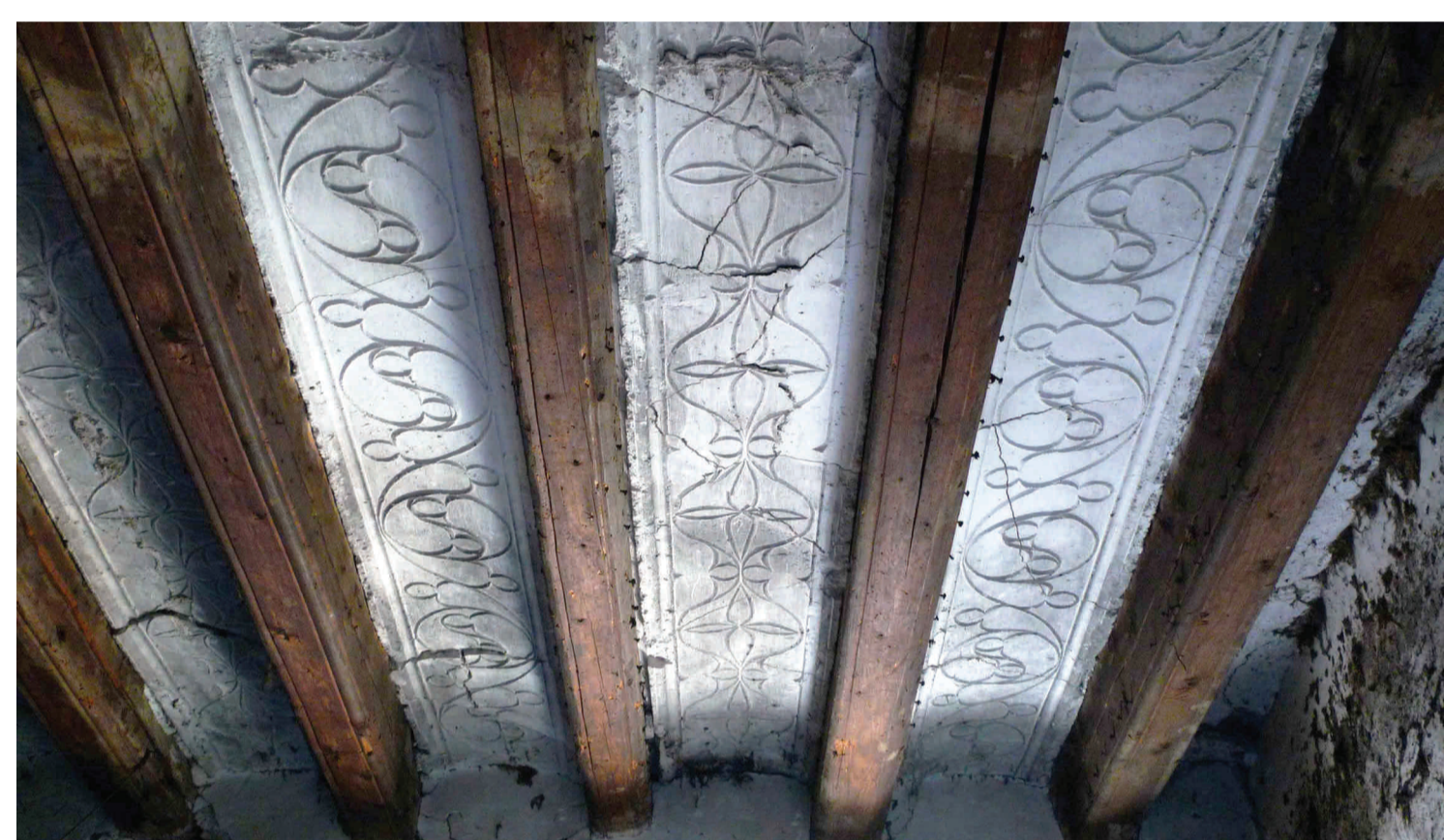
Plafond en plâtre de l'îlot de la Tour d'Argent XV e siècle
