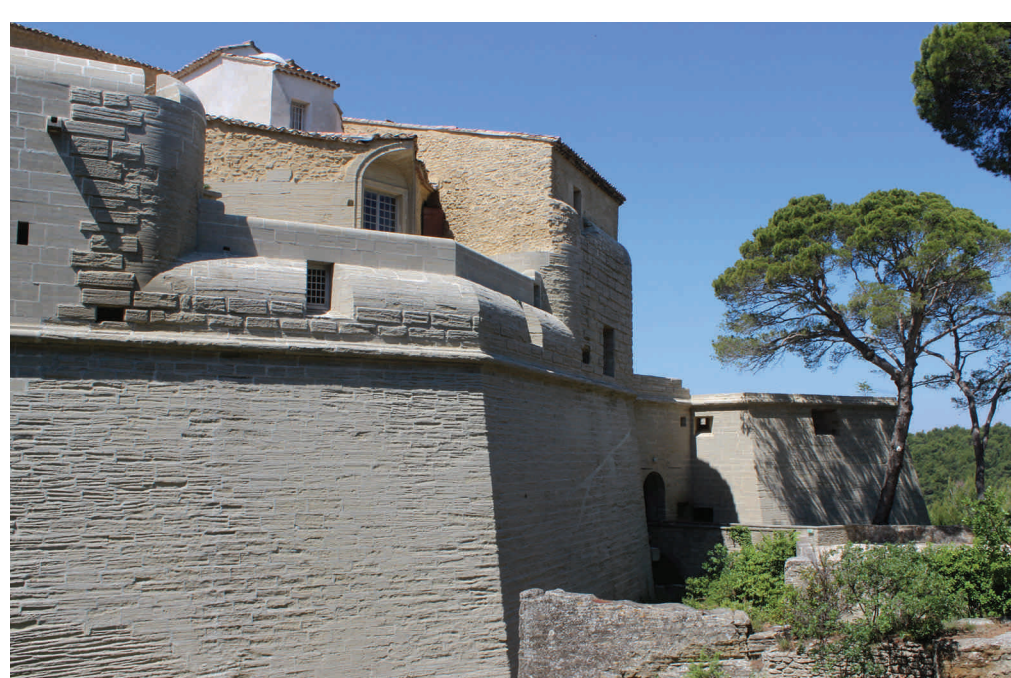
Bastion du château de Saumane récemment restauré
