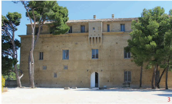
1 : Dessin de Saumane vue de l'Isle-sur-la-Sorgue, XVII e siècle © Fondation Calvet 2 : Ancienne tour à bossage, XII e siècle 3 : Logis du château de Saumane, XIII e siècle
