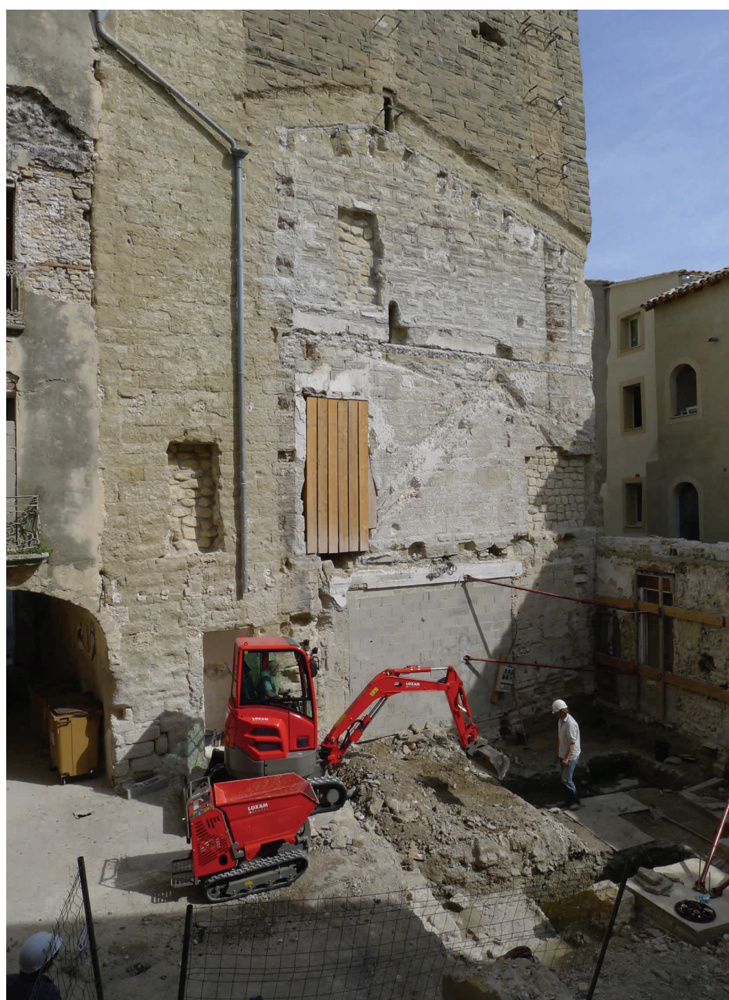
Fouille de l'immeuble Bon Juge en 2014
